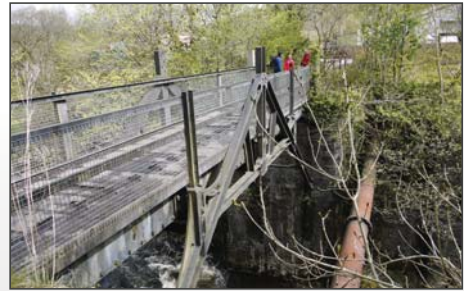
Pont y Cafnau bridge
